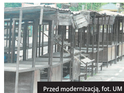
Przed modernizacją, fot. UM
