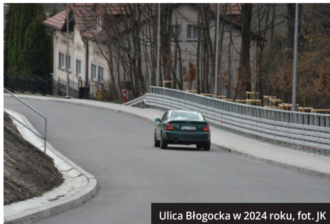
Stabilizacja osuwiska na ul. Błogockiej, fot. JK
